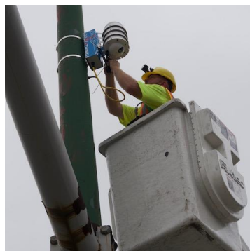
Ilustrace 8 Montáž senzoru „kvality života“ v rámci Chicaga [9]
